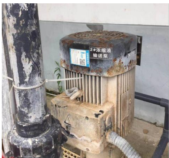
NF及RO浓缩液排入口
