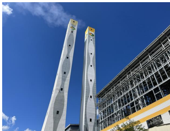
焚烧废气烟囱（右侧）
